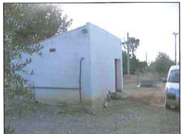
Foto. Detall de la caseta de bombes que permet el subministrament de reg a les parcel·les d'oliveres de la finca i que garantirà l'abastament d'aigua a l'almàssera
