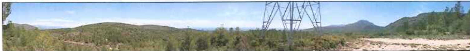
18. Vista des del tram del camí de Gran Resonerat CR-190
