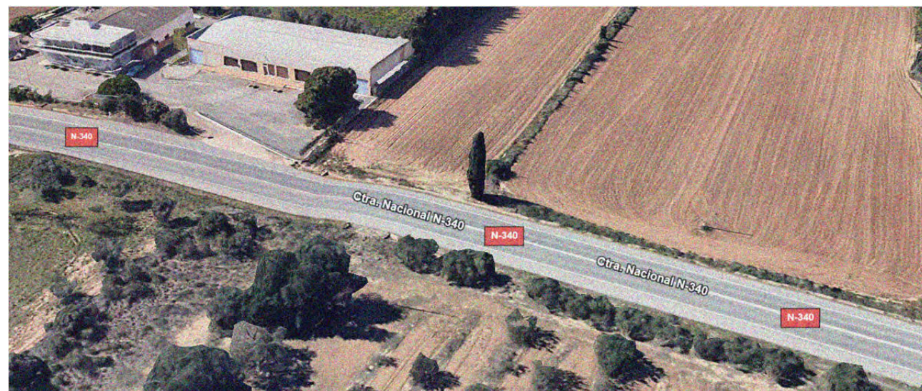
Figura 1.1 CN-340, km 1140+228 estado actual
