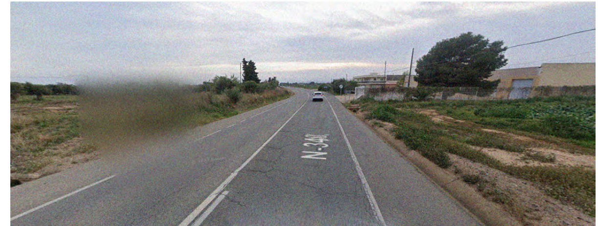
Figura 1.2 CN-340, km 1140+228 estado actual
