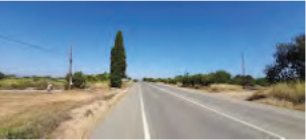
P-77 con paso aéreo de 2 ac. de cobre.jpg 221K
