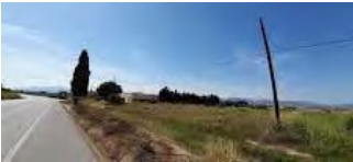
P-2262 a desmontar.jpg 200K
