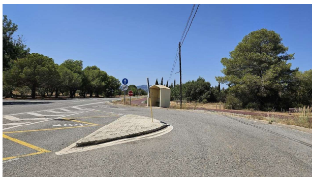
Parada de bus i carril bici en l'accés a Club Mont-roig.
