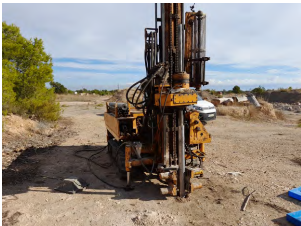
Foto 23. Localització sondeig S-1
