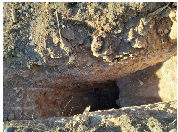
Foto 12. Calicata C-6, de 0 a 3 metres de profunditat
