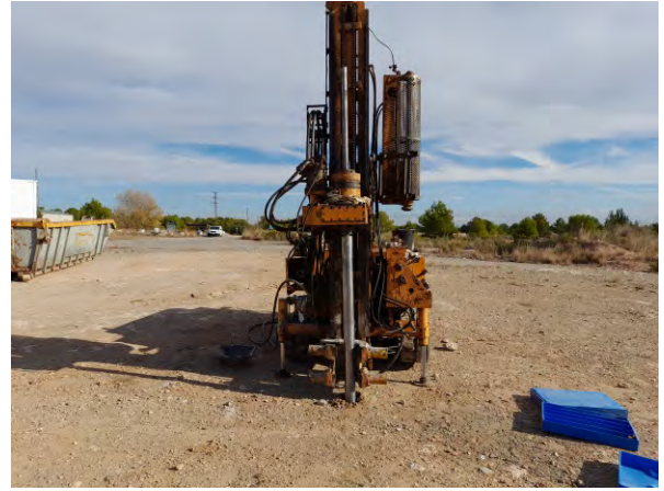
Foto 26. Localització sondeig S-2
