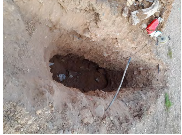
Foto 20. Calicata C-10, de 0 a 4 metres de profunditat
