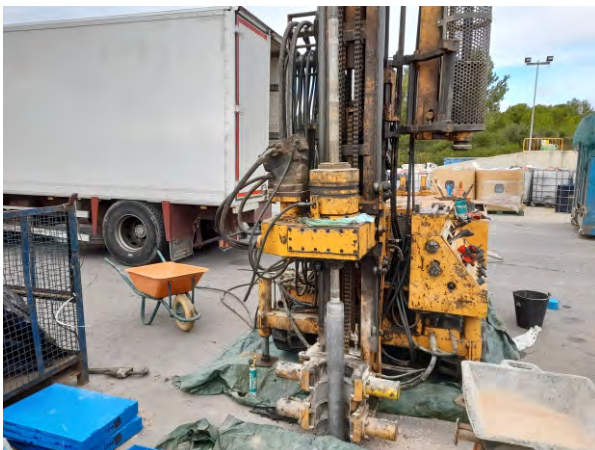
Foto 29. Localització sondeig S-3
