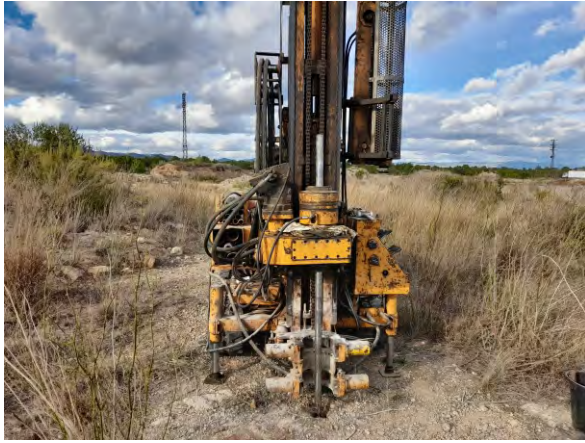
Foto 37. Localització sondeig S-4
