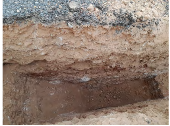
Foto 8. Calicata C-4, de 0 a 4 metres de profunditat
