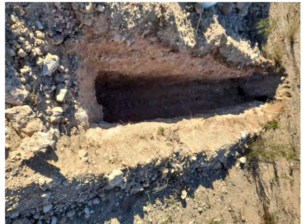
Foto 10. Calicata C-5, de 0 a 3 metres de profunditat
