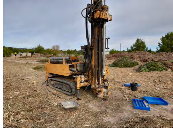
Foto 40. Localització sondeig S-5
