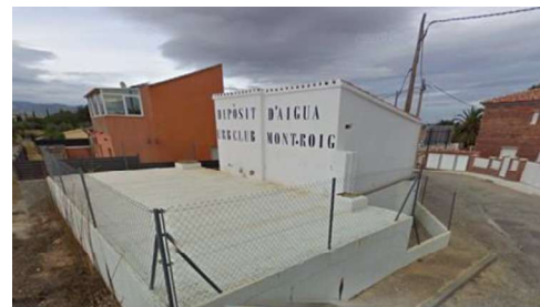
Edificación existente en la urbanización Club Mont-Roig
