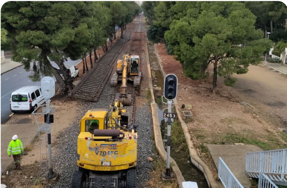
/ El primer que s'està fent és seccionar les vies i apilar-les a l'espera que trailers les retirin
