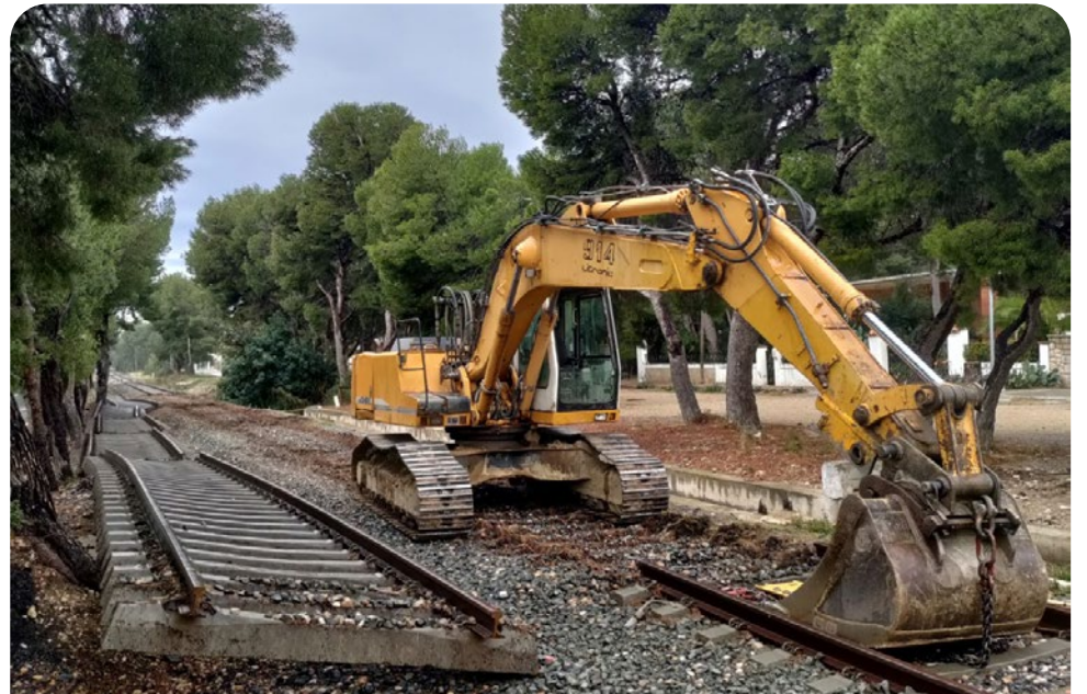
/ Els treballs continuaran amb la retirada del balast (les pedres de la via)
