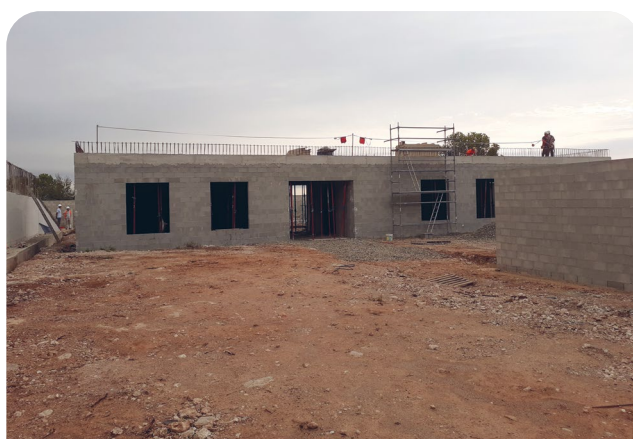
/ Estado actual de las obras de construcción de la Ecoteca
