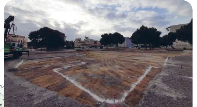
/ El nuevo edificio se está construyendo en la plaza Girona
