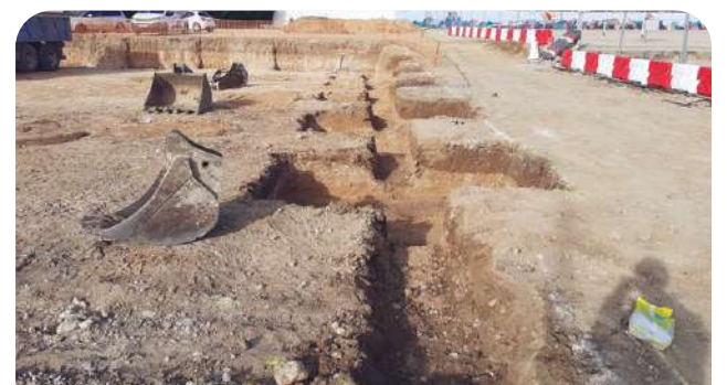
/ El pabellón se está construyendo junto a la escuela Mare de Déu de la Roca
