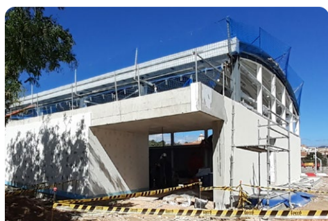
/ Evolución de las obras del Pabellón de la Roca.
