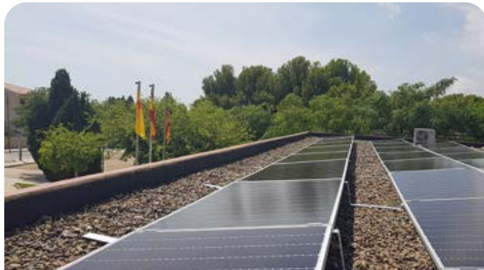
/ Les plaques fotovoltaïques s'han començat a instal·lar aquest setembre
