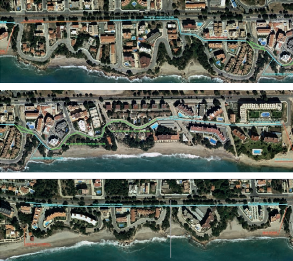
Les obres del col·lector permetran millorar el funcionament del clavegueram.
