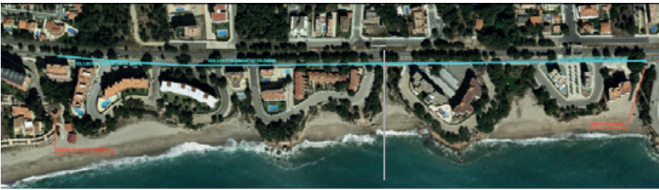
Las obras del colector permitirán mejorar el funcionamiento del alcantarillado.
