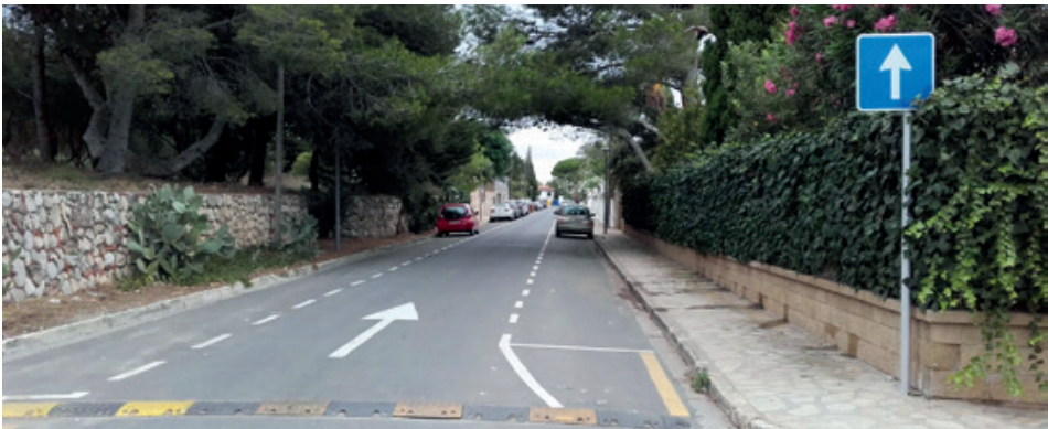
ASFALTADO Y SEÑALIZACIÓN EN MONT-ROIG BADIA
