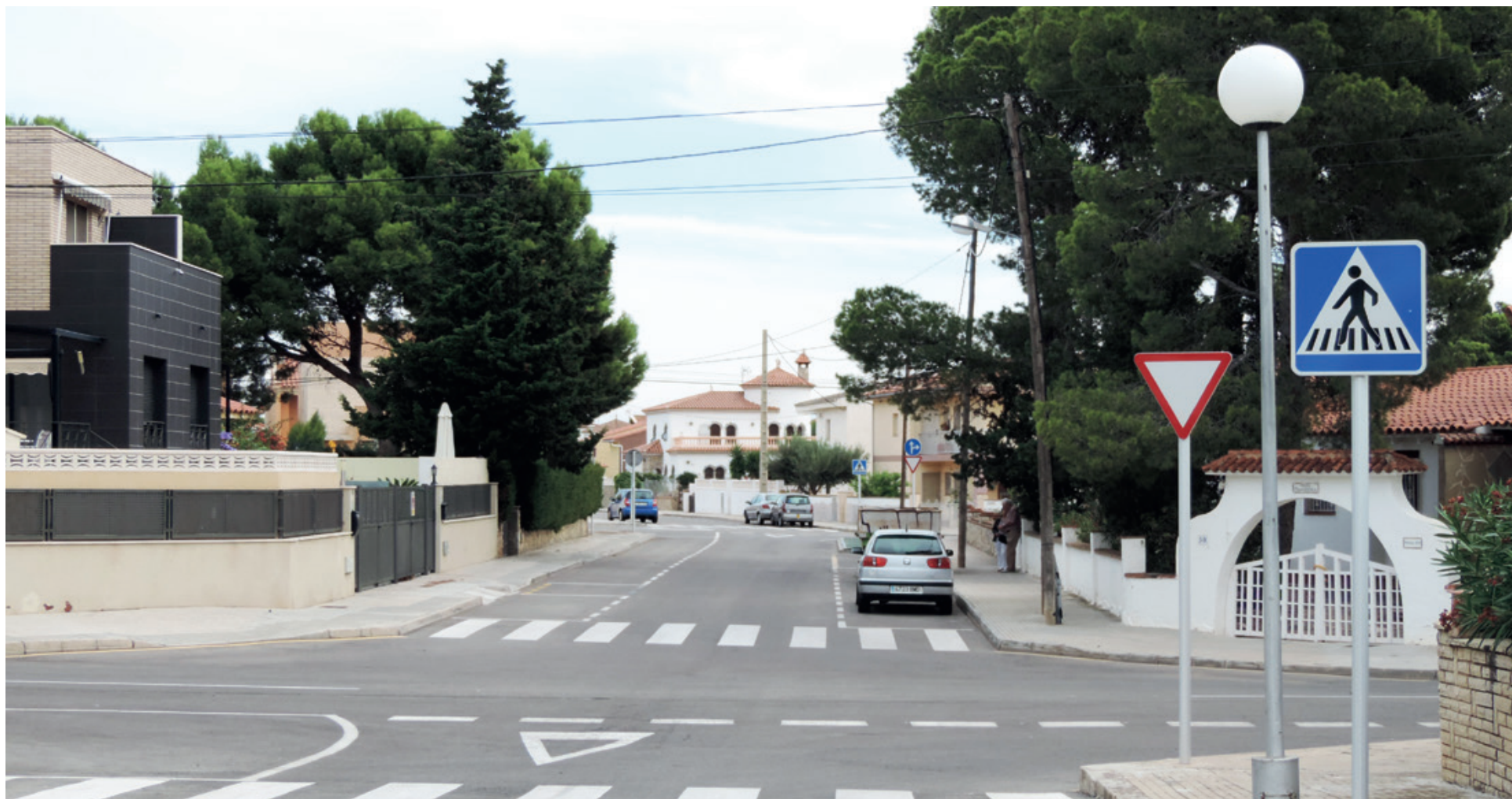
En la zona de Miami Platja se instalarán hasta 650 nuevos puntos de luz para suplir las deficiencias de iluminación.
