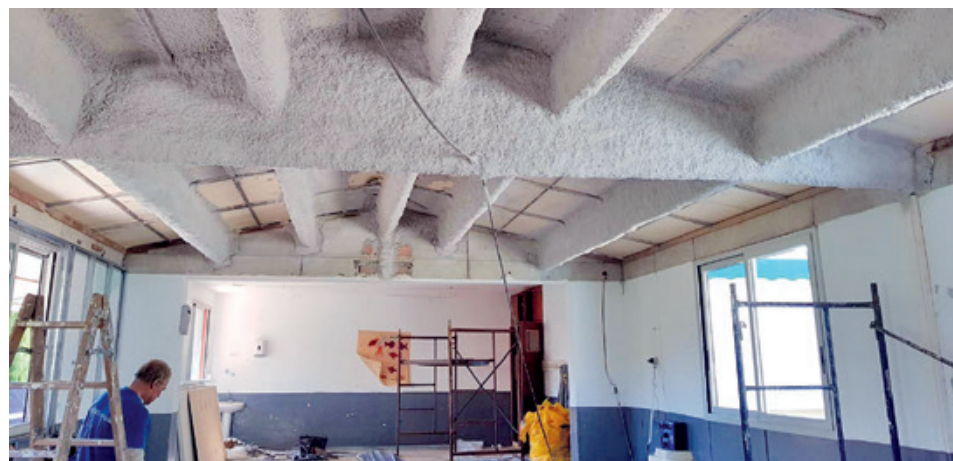
Obres al sostre del menjador de l'escola Mare de Déu de la Roca
