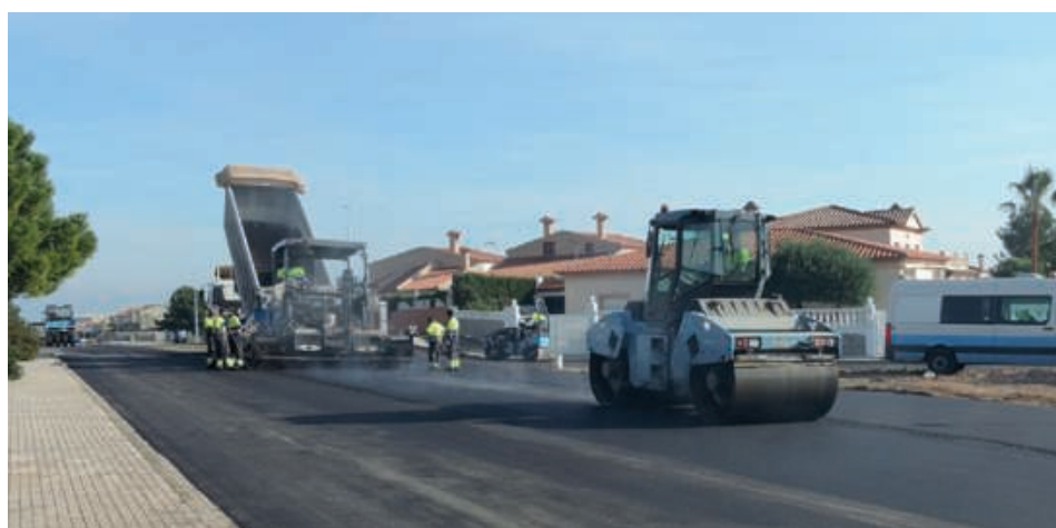
NOU ASFALTAT A DIVERSOS CARRERS DE LES URBANITZACIONS
