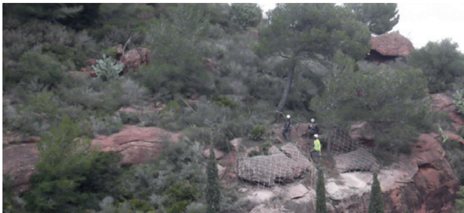
Treballs de perforació dels ancoratges i instal·lació de xarxa al voltant de l'Ermita M.D. Roca
