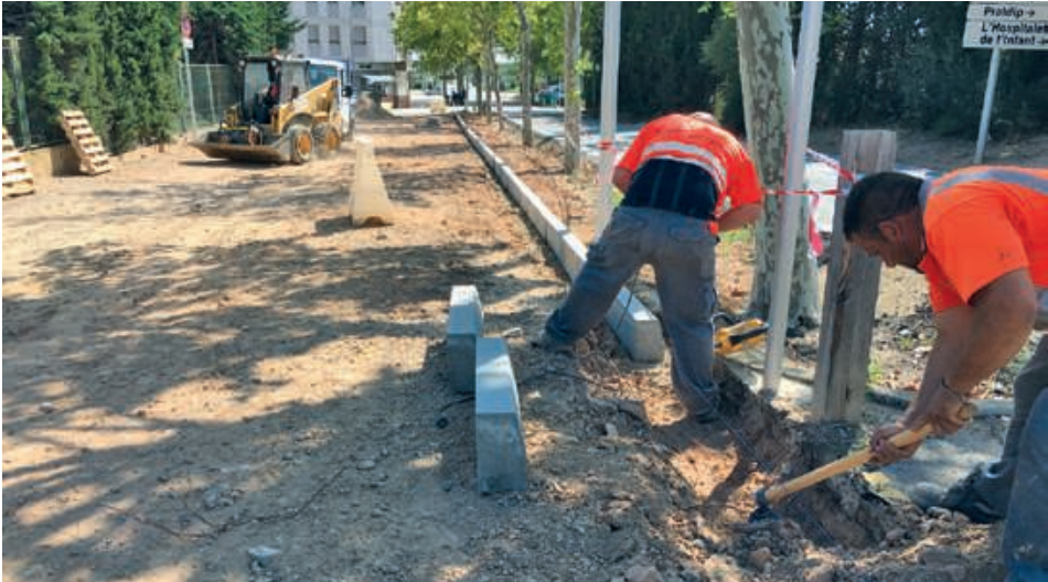
URBANITZACIÓ DE LA VORERA DE LA CARRETERA DE COLLDEJOU
