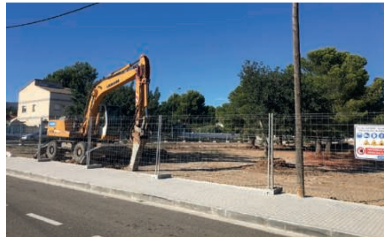
Les màquines ja estan treballant al nou parc de les Oliveres
