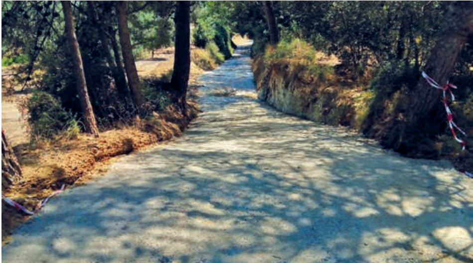
ARRANJAMENT D'UN TRAM DEL CAMÍ DE VILANOVA
