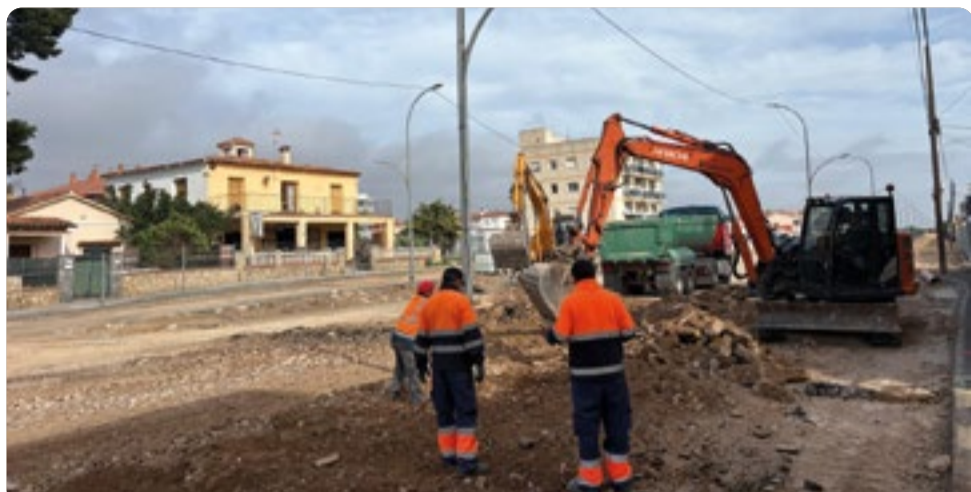
/ Las obras tienen una duración prevista de 16 meses
