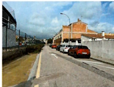
Imatge 31. Vorera poc accessible i no connectada amb l'escola.
