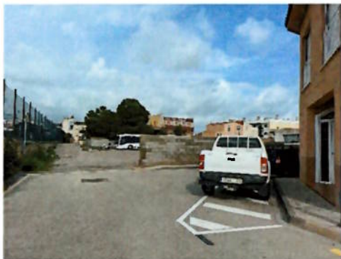
Imatge 30. Entrada supletòria de l'escola Mare de Déu de la Roca.
