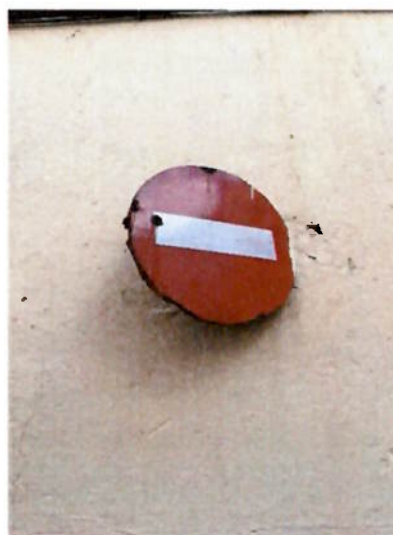
Imatge 16. Senyal en mal estat al nucli de Mont-roig.
