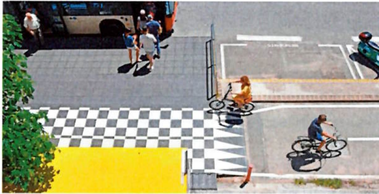
Imatge 71. Exemple de carril integrat a Barcelona. Plataforma per accedir l'autobús i integració del carril pedalable. Solució de Zicla, Sistema Vectorial
