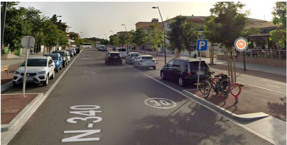
Ancoratges per bicicletes a l'N-340 – Av. Angeles. Font: Google Maps
