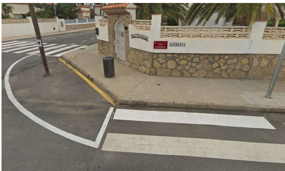
Passos de vianants no rebaixats Carrer d'Alemanya – Carrer Illes Canàries. Font: Google Maps
