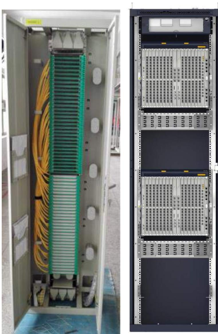
Imagen 1.1: Izquierda Armario ODF, derecha armario con OLT
