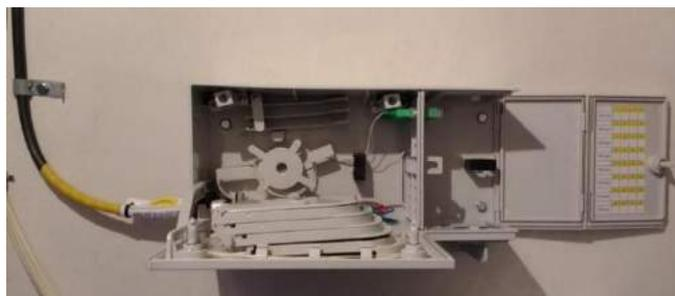
Imagen 1.8. CTO interior y Splitter 2. Detalle interior
