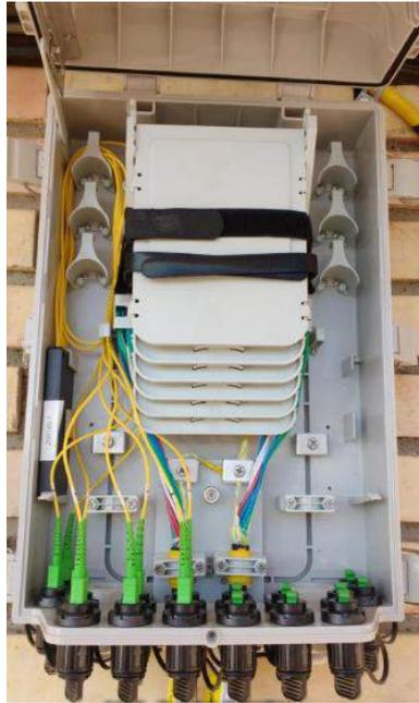
Imagen 1.6. CTO exterior 16P y Splitter 2. Detalle interior
