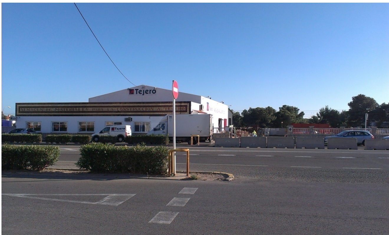
Fotografia de la zona afectada pel PAU C/ Sevilla, vista des de l'altre costat de l'Avinguda Barcelona. S'observen les peces "New Jersey" col·locades per on està prevista la prolongació del Carrer Sevilla. També s'observa la nau industrial construïda i que caldrà enderrocar per poder urbanitzar la zona afectada.
