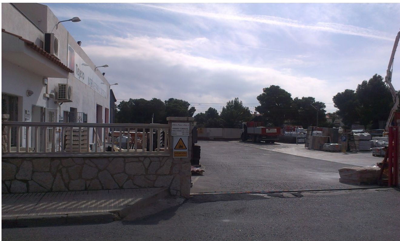
Fotografia corresponent a la porta actual a la parcel·la de l'Avinguda 195, per la via de servei que transcorre paral·lela a l'Avinguda Barcelona. S'observa que l'acabat del pati és asfaltat per una banda i amb llosa de formigó per una altre.
