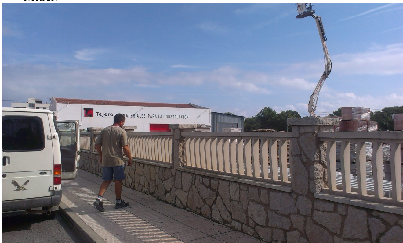
Fotografia del mur de tancament del solar de l'Avinguda de Barcelona 195.
