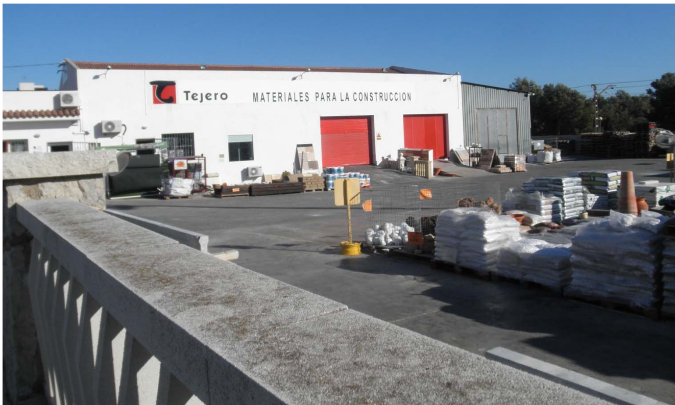
Fotografia de la nau a enderrocar per poder executar les feines marcades al projecte d'urbanització, que la nau queda sobre la parcel·la resultant amb clau urbanística 3.5.3.
