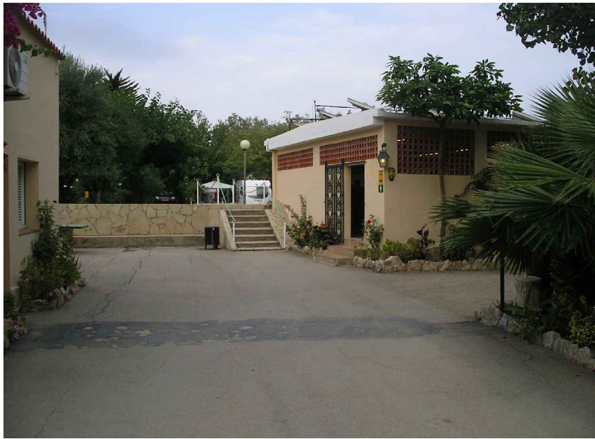
1. VISTA ACTUAL DELS LAVABOS PÚBLICS EXISTENTS I L'ESCALA QUE PUJA AL PONT D'ACCÉS
