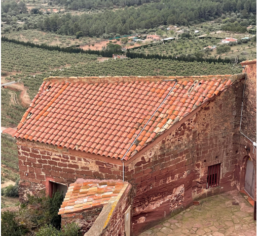
Vista V9: Detall de la teulada del volum que conté els dormitoris a la planta primera.
