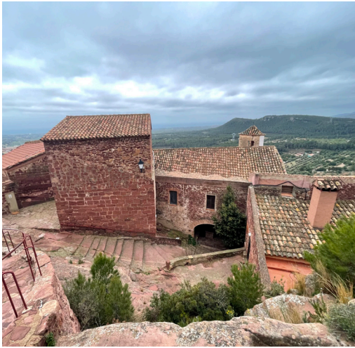
Vista V6: Detall de la porta d'accés a la zona de vestibul de la part amb arc carpanell.
