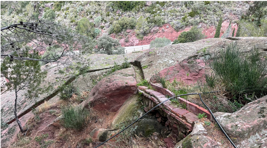
Vista V5: Canal de recollida de la font exterior del recinte
