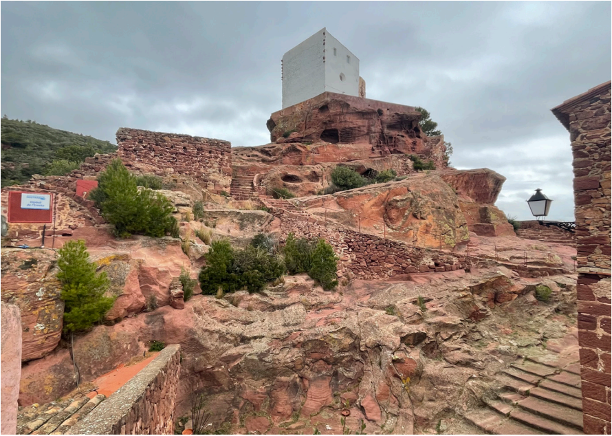
Vista V3: Façana sud. Vista aèria
